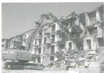
安全を追求した解体作業
